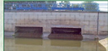
Querbauwerk an der Nebenhelme verhindert z.Z. die Fischwanderung.
